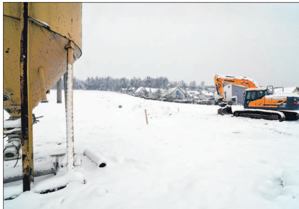
Das Gebiet „Galgenmühle-Ost“ mit 20 Bauplätzen wird erschlossen. Die Menschen werden hier künftig in der Robert-Limpert-Straße leben. F.: Jim Albright
